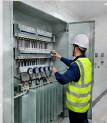
電力と情報を届けるインフラ POWER & INFRASTRUCTURE
